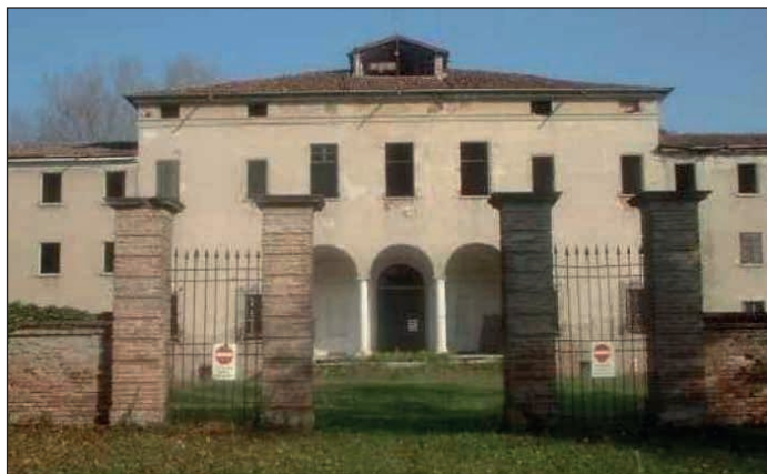
Villa Grassetti - lato sud
